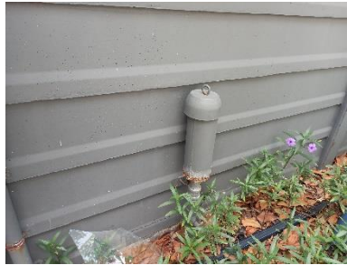
ท่อเตือนอากาศระบบบำบัดน้ำเสีย
